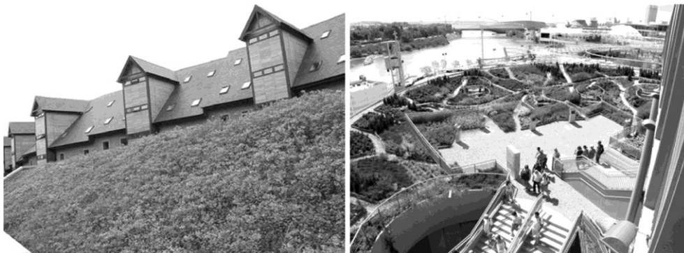
Slika 5. Zeleni krov nad podzemnom garažom i nad izložbenim halama (Greenroofs, 2021).
